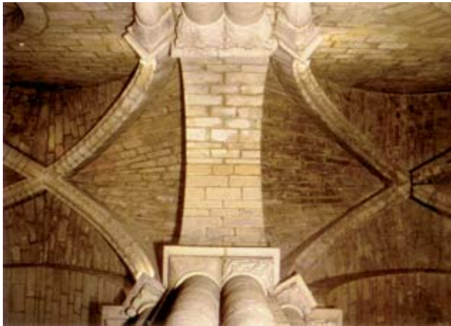
FIGURA 26. Santa María la Real de Sangüesa, basilica románica de tres naves con crucero elevado y tres ábsides, de época ya avanzada (s. XIII) de estilo muy evolucionado, con soportes compuestos de dobles semicolumnas, dobles arcos fajones y bóvedas apuntadas. (Fot. Norberto).
